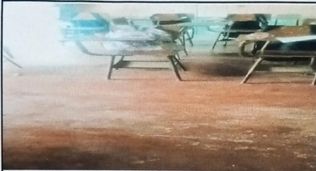
Foto1: Sustitución de piso de cemento líquido
