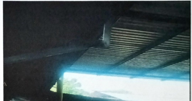
Foto 4: Sustitución de canal de metal
